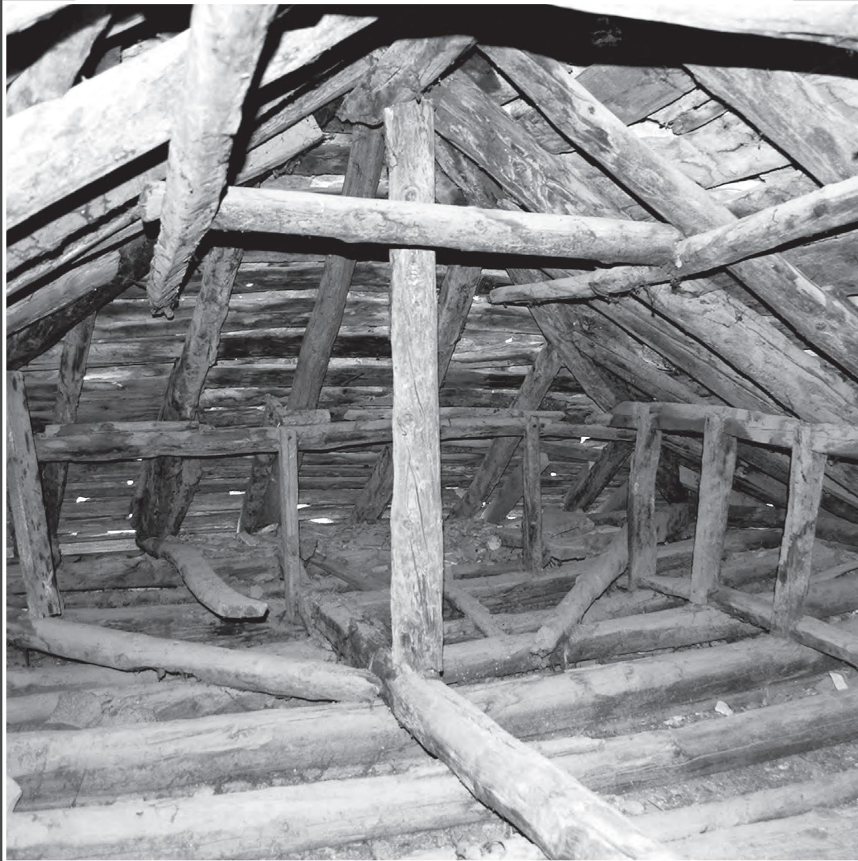
Struttura lignea di copertura di un'abitazione tradizionale ad Argirocastro, Albania (ph.Federica Pompejano, 2015).
